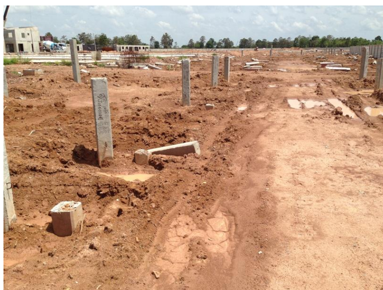
รูปที่ 4.4 งานเสาเข็ม
