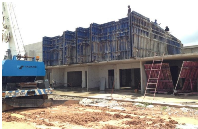
รูปที่ 4.9 งานผนังรับน้ำหนักชั้น 2
