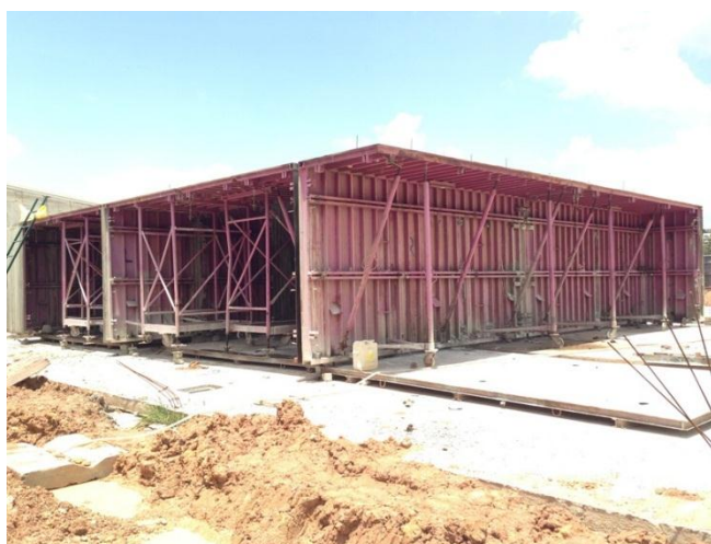
รูปที่ 4.8 งานผนังรับน้ำหนักชั้น 1 และพื้นชั้น 2
