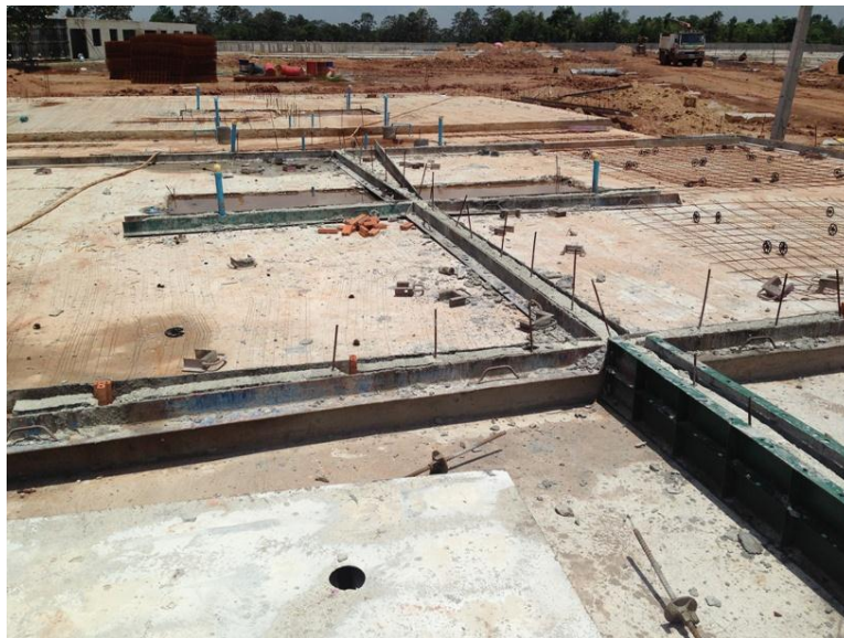
รูปที่ 4.7 งานพื้นชั้น 1 และเตรียมการเข้าแบบผนังชั้น 1
