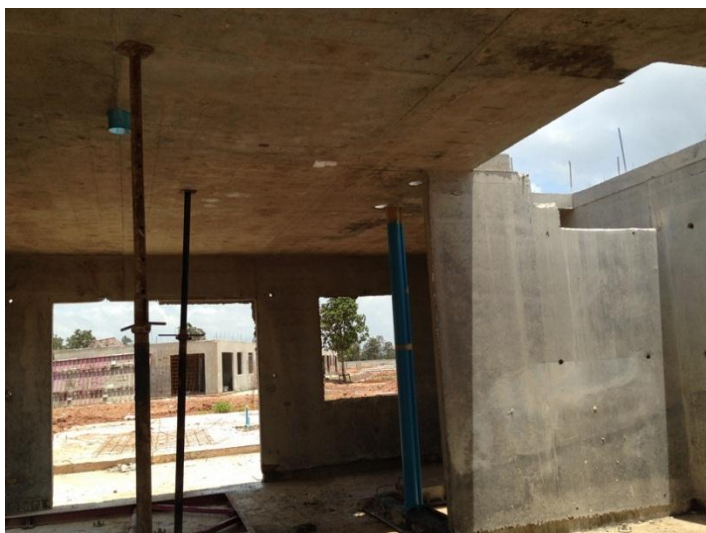
รูปที่ 4.11 งานระบบประปา สุขาภิบาล ระบบไฟฟ้า
